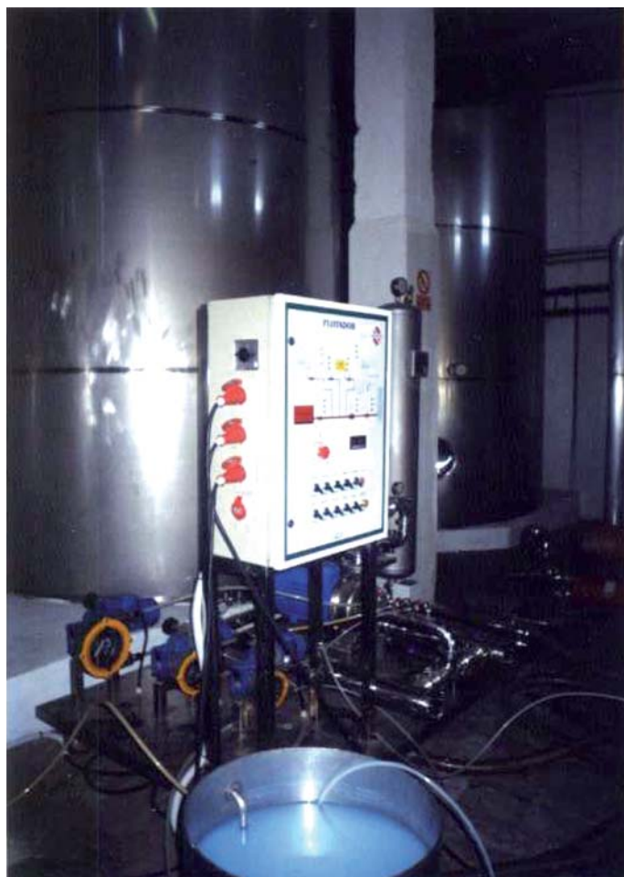
Foto 1. Equipo trabajando en bodega.
